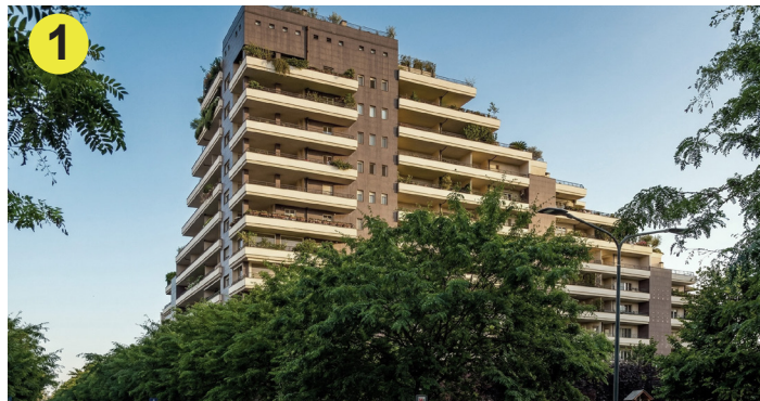
1_ REALIZZATO NEL 2012 Via Lorenzini-Via Adamello
