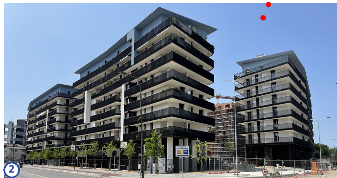
Intervento ultimato - Via dei Canzi Soc. Coop. Edilizia Sant'Ilario-nr. 195 alloggi e 2 negozi
