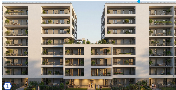
Intervento prossimo all'inizio lavori in Via Crespi, 28 Soc. Coop. Edilizia Sant'Ilario-nr. 77 alloggi ED.LIBERA
